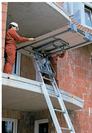
Einsatz mit Kippschlitten für individuelles Ankippen zur bequemen Materialentnahme
